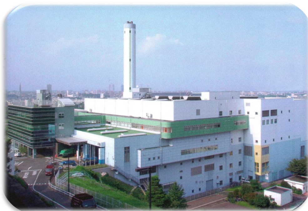
クリーンセンター多摩川全景
