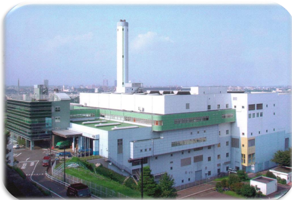
クリーンセンター多摩川全景
